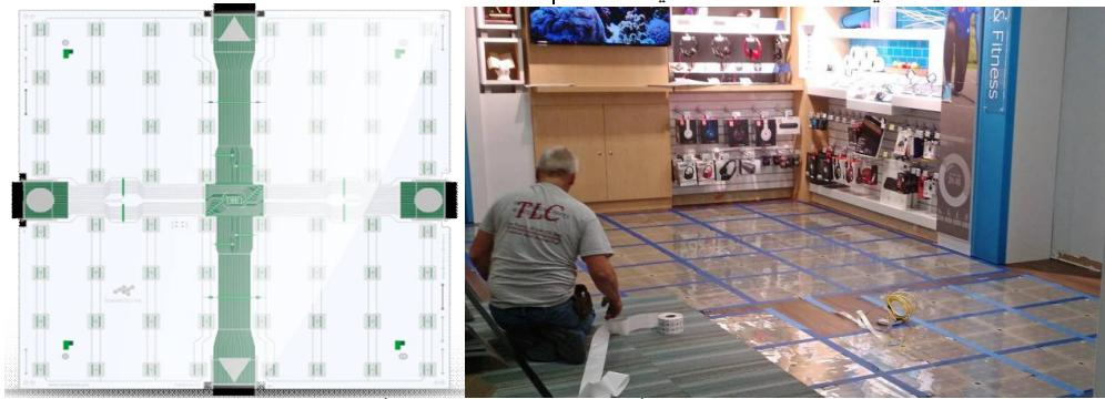
تدعى Sens floor تدعى Sens floor تستطيع ان تطلق نداء مساعدة عند سقوط احد عليها ،ويبلغ سمكها حوالي 3مم فقط ويوجد تحت كل متر مربع منها ما يقارب 32 جهاز استشعار يعمل على الاستشعار بسقوط الاشياء عليها وارسال تنبيه وانذار في نفس الوقت . (صورة رقم 6)
